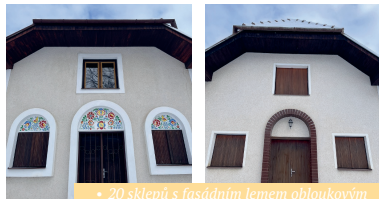
• 20 sklepů s fasádním lemem obloukovým • 25 sklepů s lemem obdélníkový
