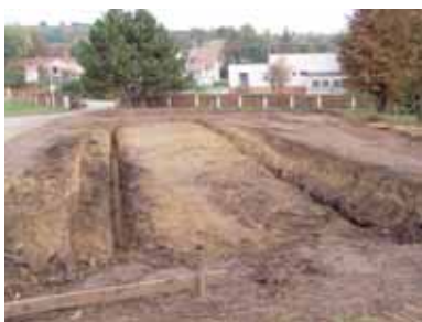
Výstavba pečovatelských bytů zahájena
