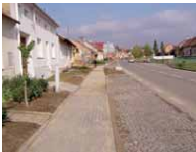
Nové bezbariérové chodníky
